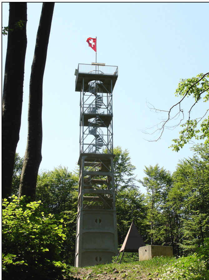
Der Aussichtsturm auf dem Wisenberg wurde im Jahr 1927 erbaut. Da der Wald immer höher wuchs, musste der Turm 1953 und 1987 aufgestockt werden. Foto: Niklaus Tanner.
