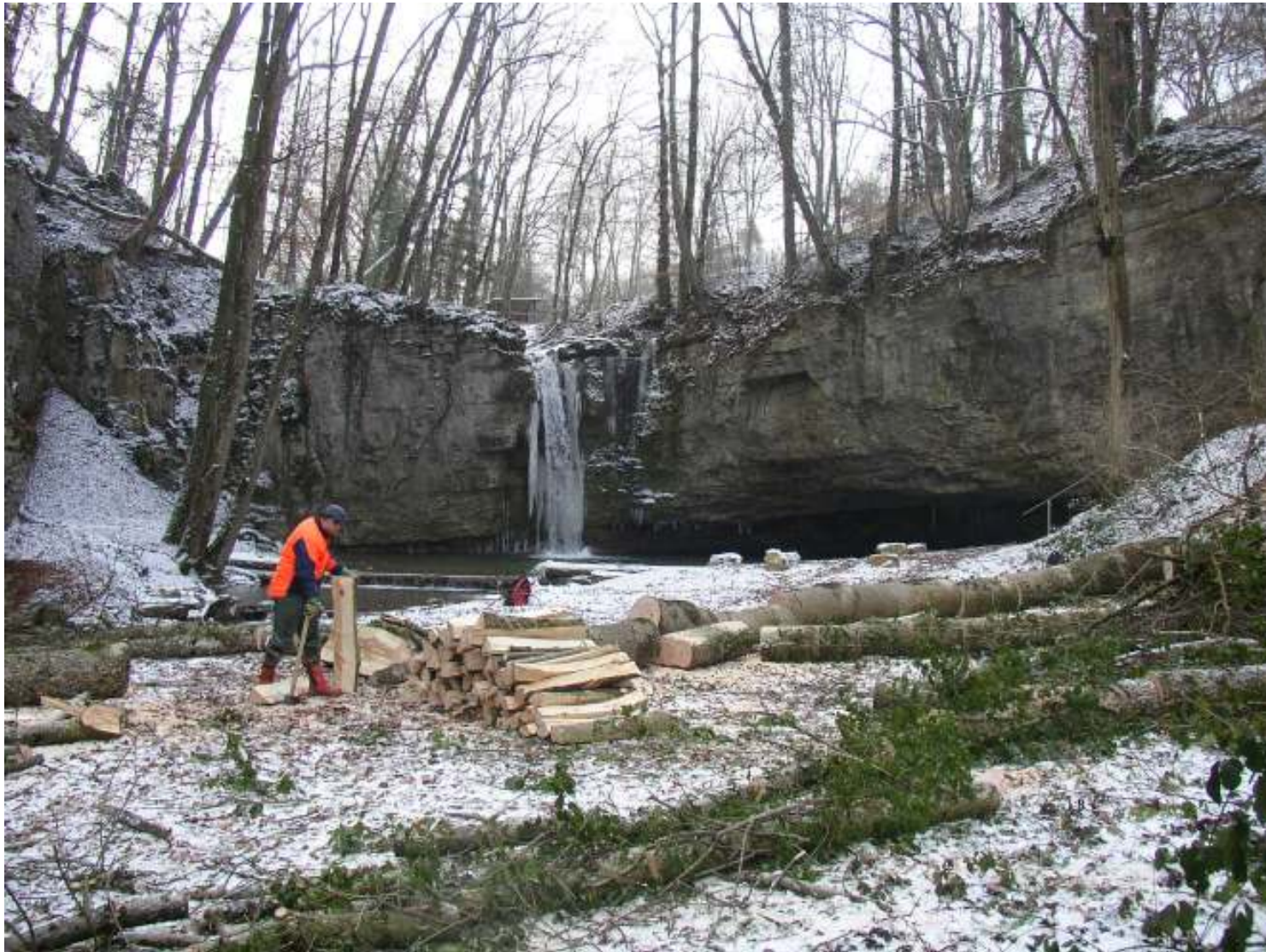
Projekt: Wässermatten und Auen im Eital
