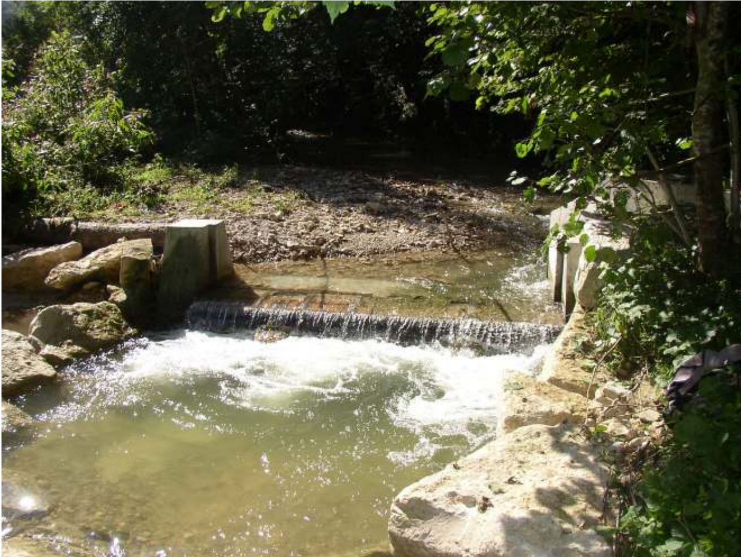
Projekt: Wässermatten und Auen im Eital
