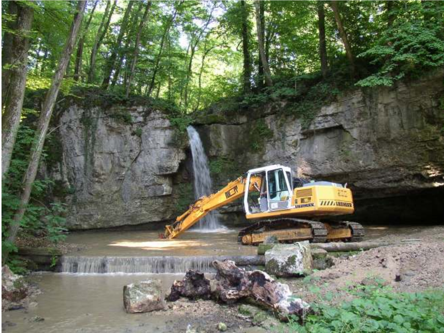
Projekt: Wässermatten und Auen im Eital
