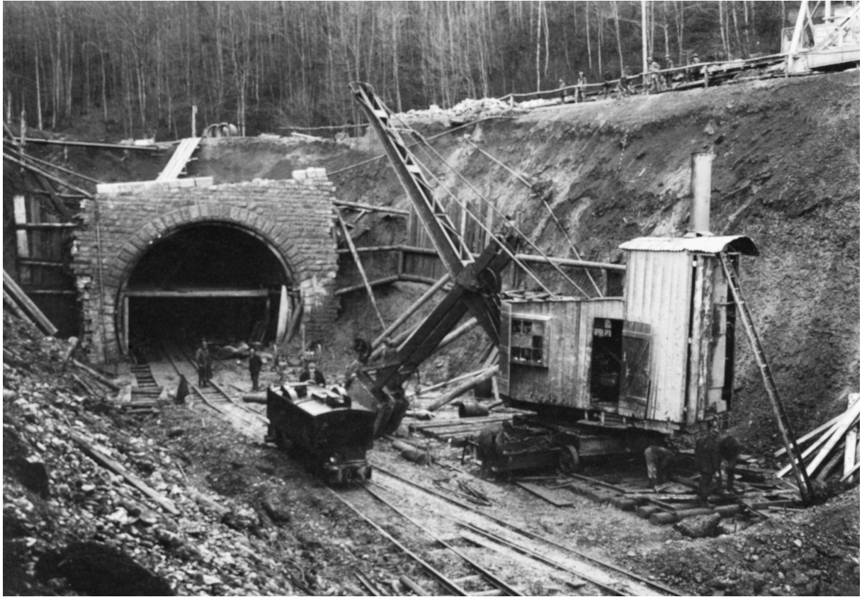
Tunnelbau in Tecknau ca. 1912
