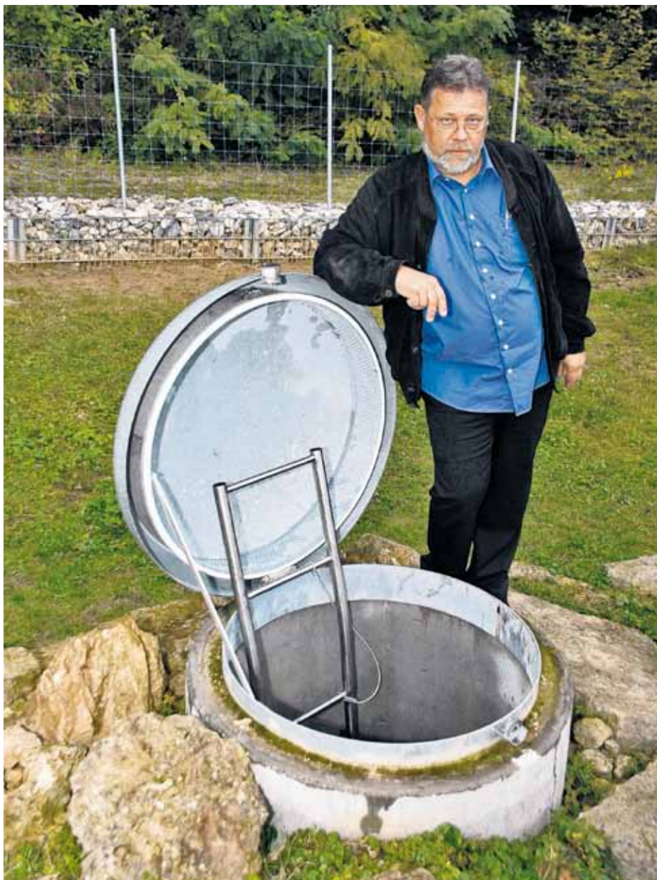
Das unterirdische Reservoir von Peter Staub fasst 50 000 Liter Wasser.
